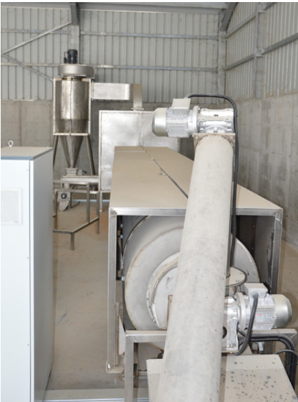
Essiccatoio per digestato solido, che dopo pellettizzazione è venduto come concime organico
