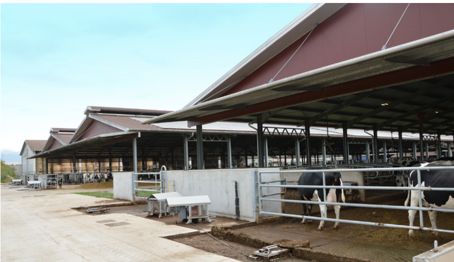
Una nuova stalla da 250 capi è stata realizzata nel 2021, assieme a un impianto fotovoltaico da 300 kW (visibile sulla tettoia del capannone centrale)
