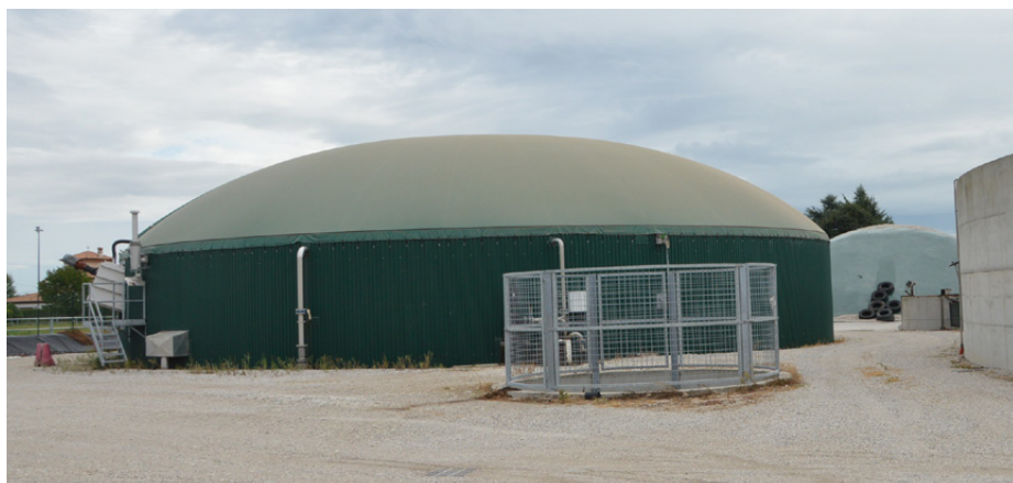
Biodigestore da 250 kW, alimentato esclusivamente con reflui aziendali. Fornisce digestato liquido e solido nonché calore per l'essiccamento di quest'ultimo e la climatizzazione dell'acqua di abbeverata
