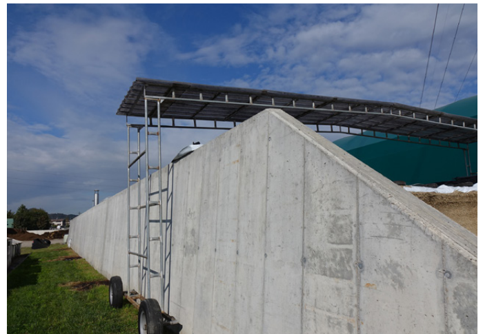
Due dettagli della semplice ma decisiva struttura applicata alla trincea per evitare che il fronte di taglio venga eccessivamente bagnato dalla pioggia
